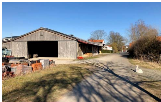
und auf vorhandene Betriebsgebäude.
