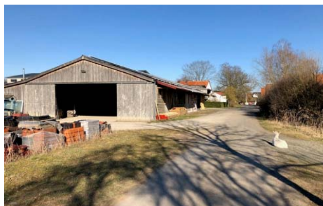
und auf vorhandene Betriebsgebäude.
